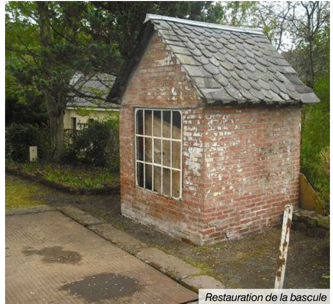
Restauration de la bascule
