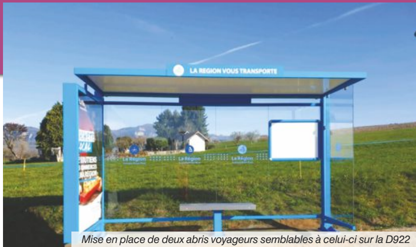
Mise en place de deux abris voyageurs semblables à celui-ci sur la D922
