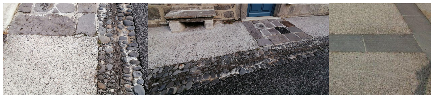
L'utilisation et l'association de dallages en pierre volcanique avec du béton désactivé pour l'abords des bâtiments reprendront l'esprit des aménagements précédents. La voirie du centre ancien est prévue en enrobé clair ou grenailé. Les rues secondaires seront en enrobé gris.
