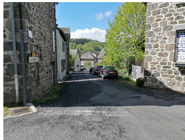
Rue des Gantiers à requalifier, aspect routier à effacer en priorisant un sens de circulation.
